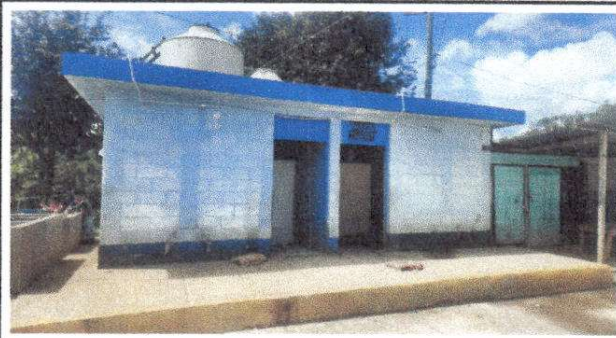
Foto13: Pintura en muros exteriores
