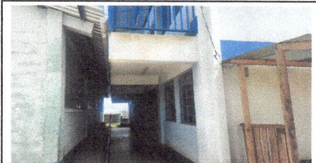
Foto 10: Pintura en muros exteriores e interiores del módulo 1
