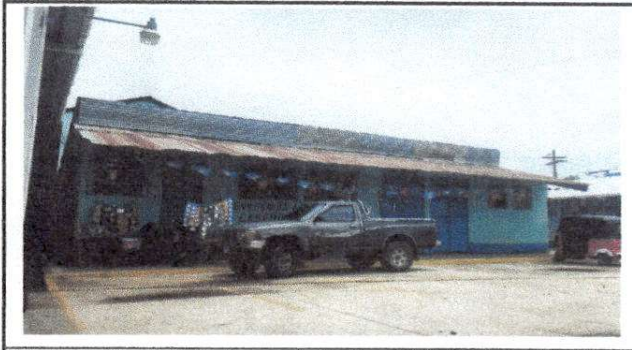
Foto 8: Sustrucción de lámina, por lámina troquelada aluzinc calibre 26 en módulo 4
