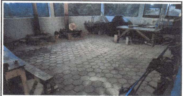
Foto 4: Sustitución de adoquin por piso granito en módulo dos cocina
