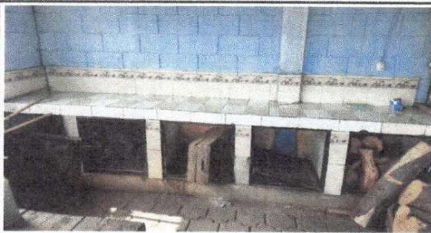
Foto 3: Sustitución de estructura de metal de puertas del meson del módulo 2 cocina
