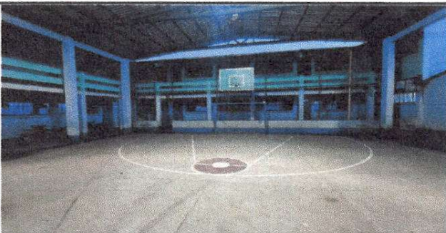
Foto 11: Pintura en muros exteriores e interiores del módulo 3
