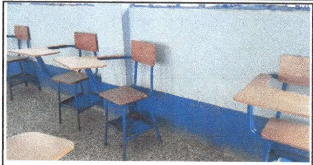
14: Pintura en muros interiores del modulo 1
