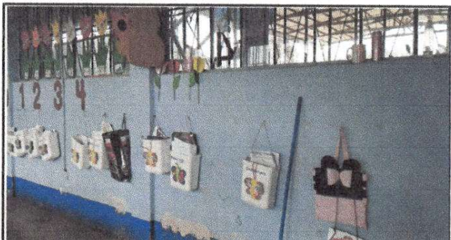
Foto 16: Pintura en muros interiores del modulo 1
