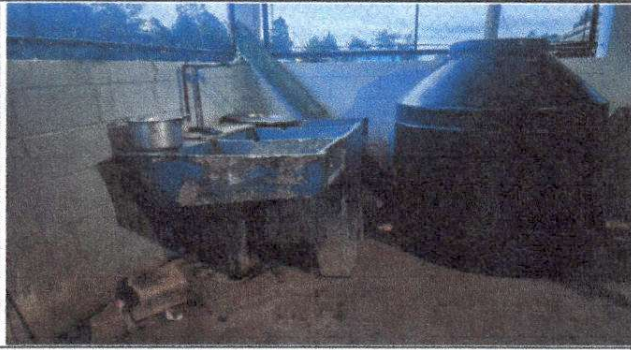
Foto 7: Sustrucción de pila de cemento de dos lavaderos por pila de concreto fundida en módulo 2 cocina
