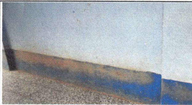
Foto 15: Pintura en muros interiores del modulo 2
