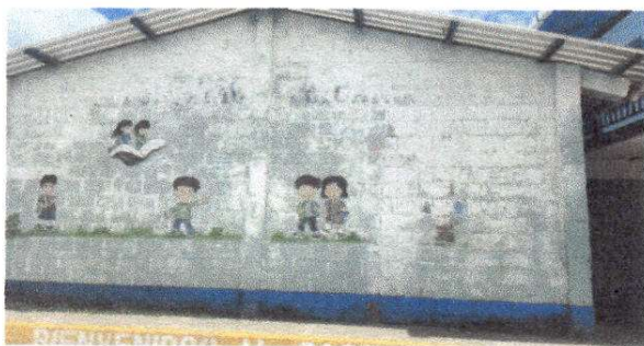
Foto 5: Pintura en muros exteriores e interiores del módulo 2
