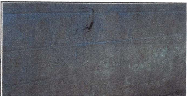
Foto 18: Pintura en muros interiores modulo 4
